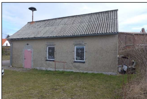
Altes Feuerwehrgerätehaus, dahinter Garage, beides für Abbruch vorgesehen), rechts davon Schuttlager
