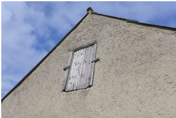
Dachbodenluke Feuerwehrgerätehaus, außerhalb GB
