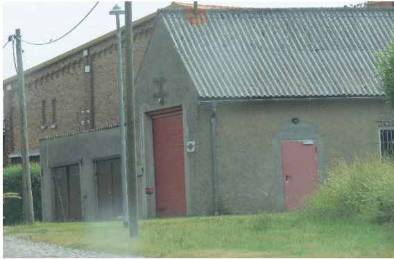
Ansicht altes Feuerwehrgerätehaus, kein Eingriff
