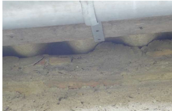
Hohlräume unter dem Dach, außerhalb GB
