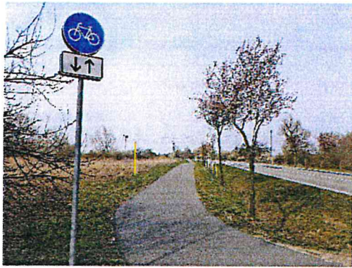
Radweg: Nbg. – Woggersin
