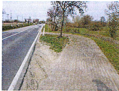
Radweg: Nbg. – Woggersin
